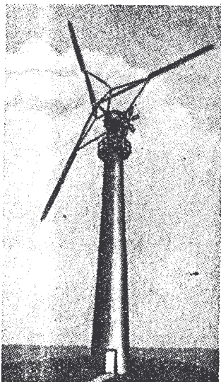
Rys. 174. Zespół wiatrowo-elektryczny syst. Smitha
